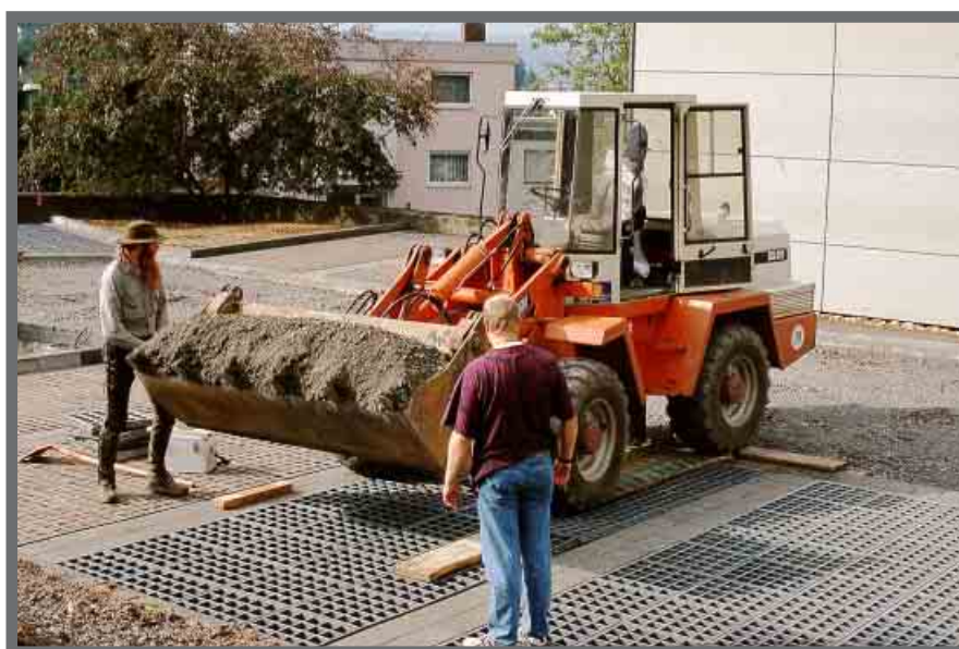
Fugenverfüllung nach dem Verlegen auf 2-3 cm Ausgleichsschicht.
