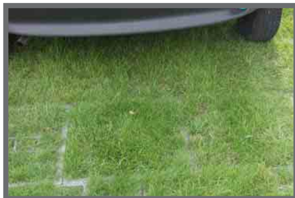
TTE-Rasengitter im Fugenversatz im Sommer 2002.
