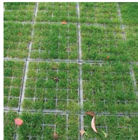
TTE® Rasengitter im Fugenversatz im Sommer 2002
