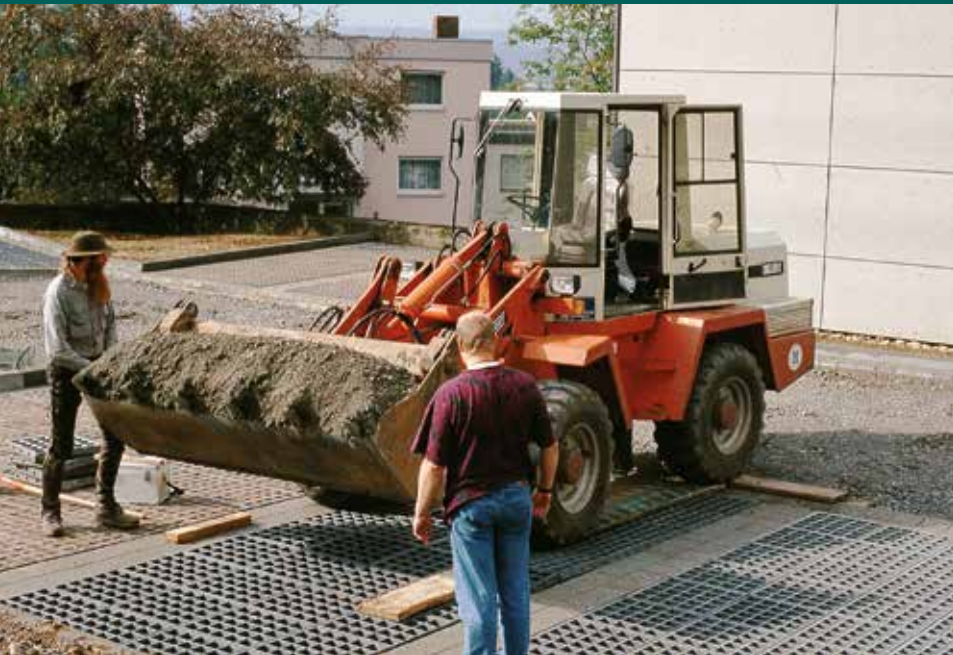
Fugenverfüllung nach dem Verlegen auf 2-3 cm Ausgleichsschicht
