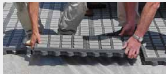
Благодаря системе TTE® быстро и просто создается экологичная мостовая для постоянно хорошего впитывания влаги.
