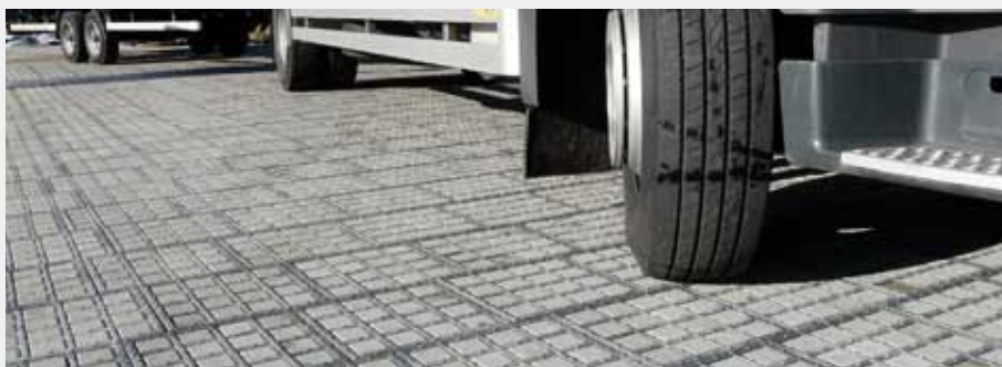
Дорога для грузовых автомобилей TTE® всего примерно на 25 см минерального несущего слоя на глинистой почве, заполнение брусчаткой TTE®. Уникальный показатель водопроницаемости (ок. 30 л/м 2 в секунду) позволяет избежать образования луж и скопления тонкой пыли.
