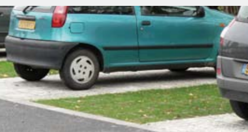
TTE®-PKW-Parkplätze: begrünt und TTE®-Pflaster im Wechsel, direkt auf Oberboden realisiert.
