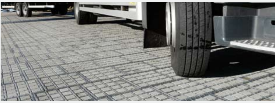
TTE® LKW-Fahrstraße auf nur ca. 25 cm mineralischer Tragschicht auf lehmigem Boden, verfüllt mit TTE®-Pflastersteinen. Die enorme Wasserdurchlässigkeit (ca. 30 l/m 2 pro Sekunde) verhindert Pfützenbildung und tilgt Feinstaub.
