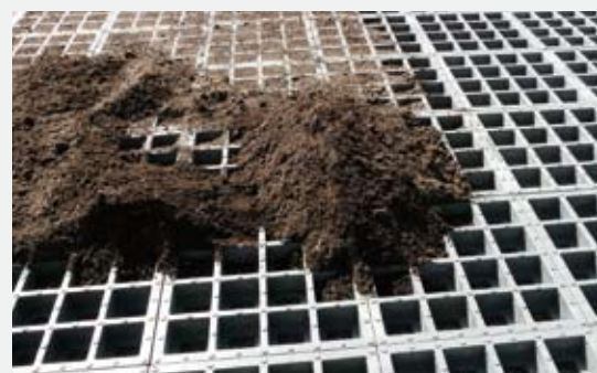
Für die Begrünung wird das TTE® Multi-DrainPLUS mit einem lockerem Gemisch aus Oberboden, Sand und Feinkies verfüllt.
