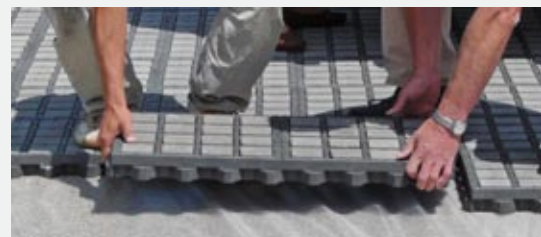
Schnell und einfach entsteht mit dem TTE®-System eine ökologische Pflasterfläche für dauerhafte Versickerung.
