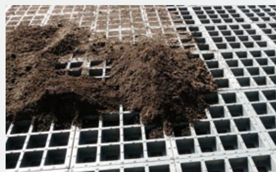
Für die Begrünung wird das TTE® Multi-Drain PLUS mit einem lockeren Gemisch aus Oberboden, Sand und Feinkies verfüllt.
