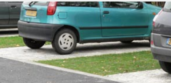
TTE®-PKW-Parkplätze: begrünt und TTE®-Pflaster im Wechsel, direkt auf Oberboden realisiert.
