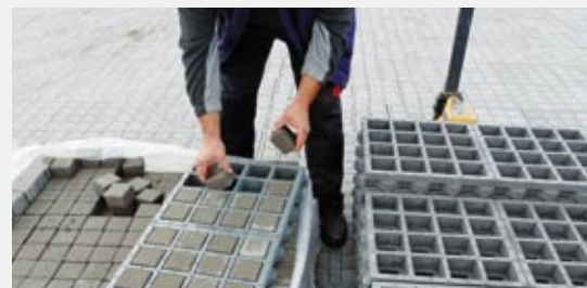
Zuerst auf der Baustelle die TTE®-Pflastersteine einstecken und dann verlegen. Mit Hubwagen die Paletten nachrücken.
