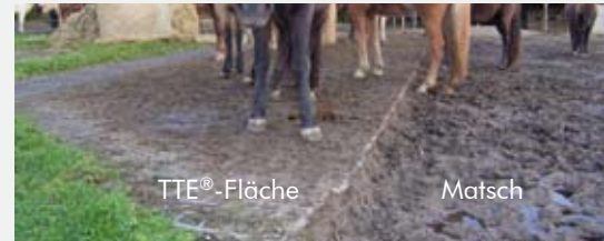
Diese Schlechtwetterfläche wurde direkt auf Matsch gebaut. Teilbefestigungen sind jederzeit erweiterbar.
