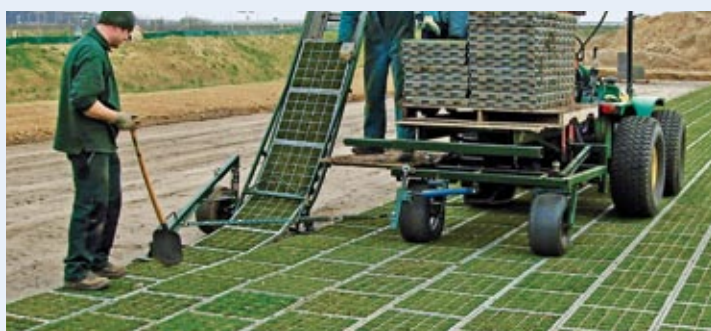
Machinaal leggen van TTE ® Direct Groen bij grote oppervlakten.
