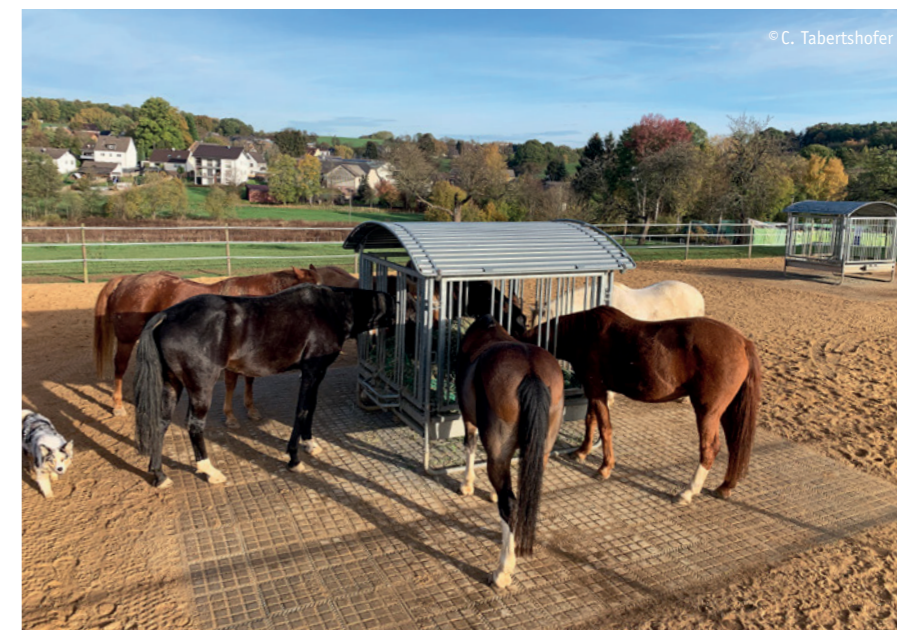
Paddockfläche aus Multidrain-Platten ohne Unterbau, teils mit Betonsteinen, teils mit Sand verfüllt
